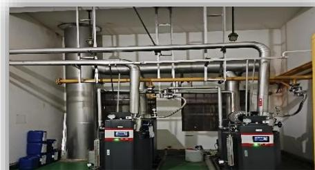
更换锅炉为一级蒸汽蒸发器，以降低蒸汽能耗和水耗
